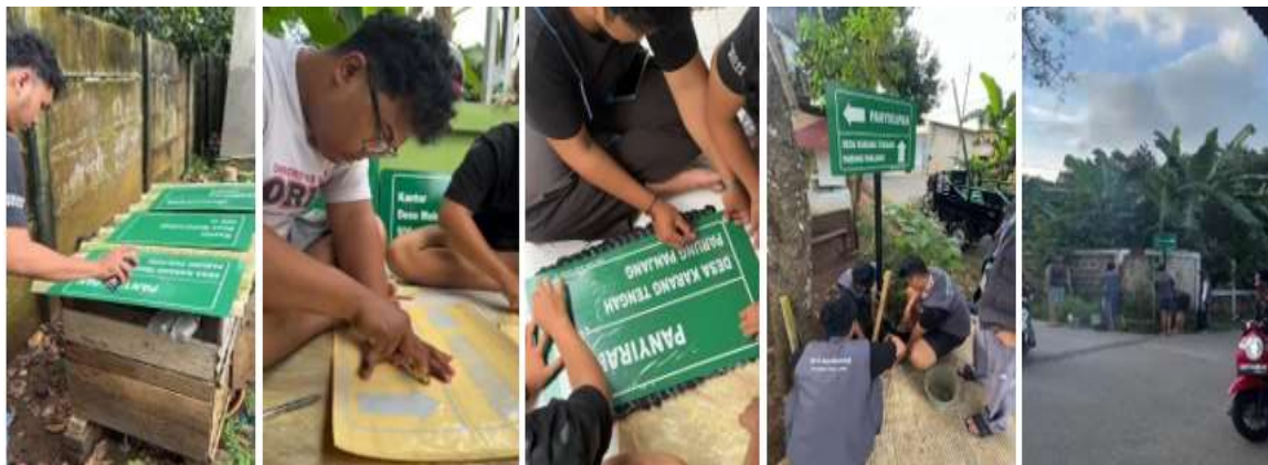
Gambar 3. Pemasangan Sign System
