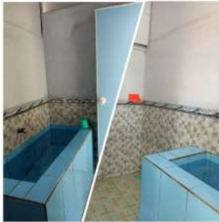
Gambar 5. Kondisi sarana sanitasi pasca perbaikan
