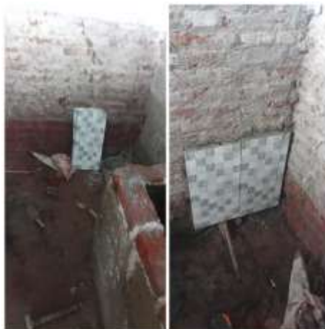
Gambar 3. Proses Perbaikan Toilet Musholla Al-Amin
