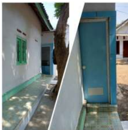
Gambar 4. Kondisi akses jalan sarana sanitasi pasca perbaikan
