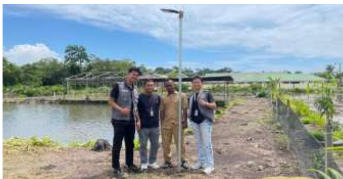
Gambar 6. Serah Terima Lampu Tenaga Surya di Kawasan Pemancingan Kelurahan Sesumpu
