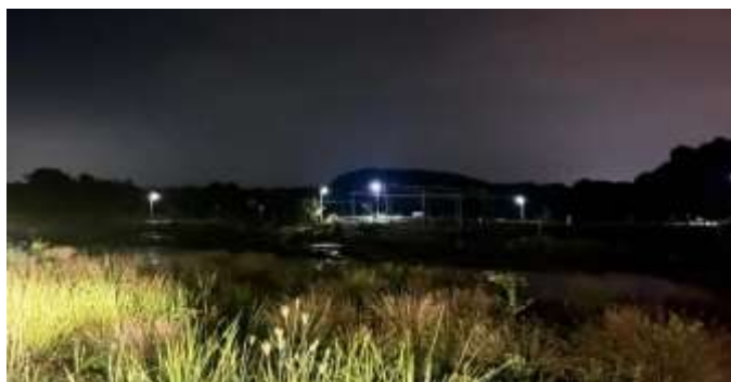
Gambar 5. Hasil uji coba kelayakan Pemasangan Lampu Tenaga Surya di Kawasan Pemancingan Kelurahan Sesumpu
