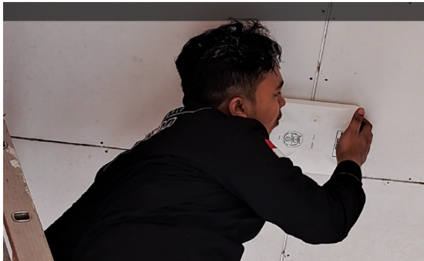
Gambar 7. Pemasangan Akses Point
